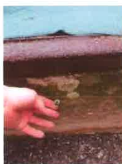
2) Absence gumových úchytů na uchycení plachty
